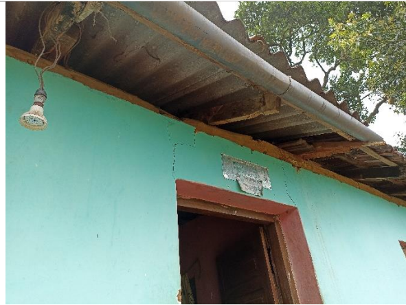
படம் I- 5: செல்வி. சோபியாவின் வீட்டில் விரிசல், வெளிப்புறமாக
